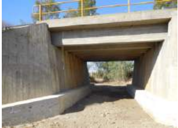
Fig. 13. Adaptação de passagem inferior com passadiço para a fauna na EN122.
