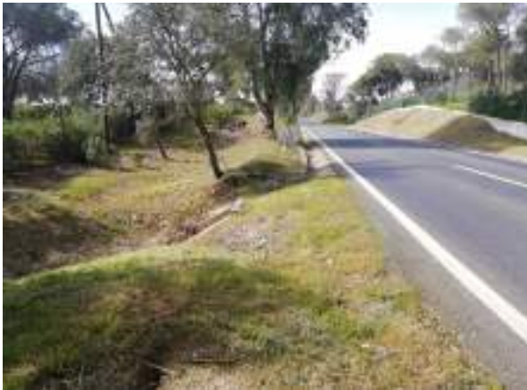
Fig. 14. Bermas da estrada limpas de vegetação.
